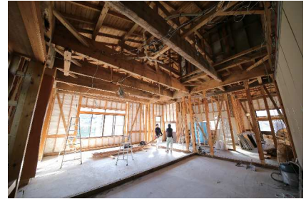
既存躯体確認の工事現場 TTハウス
